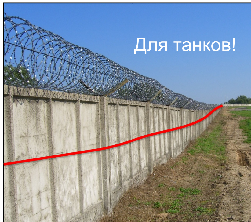
Реализация: Трибоэлектрическая система «Г»
